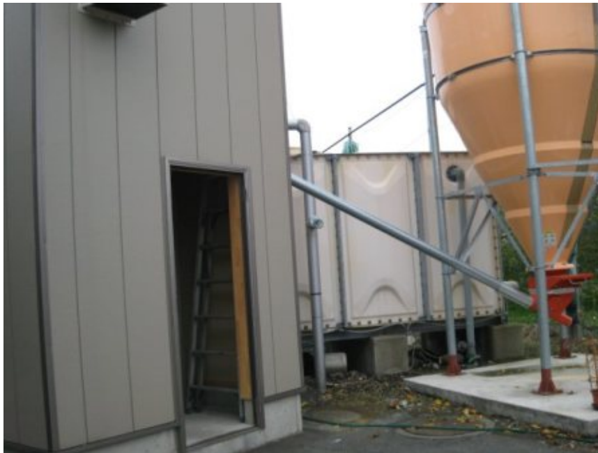
図2 実施後設備 (上: バイオマスボイラー 下: サイロとボイラー設置場所)
