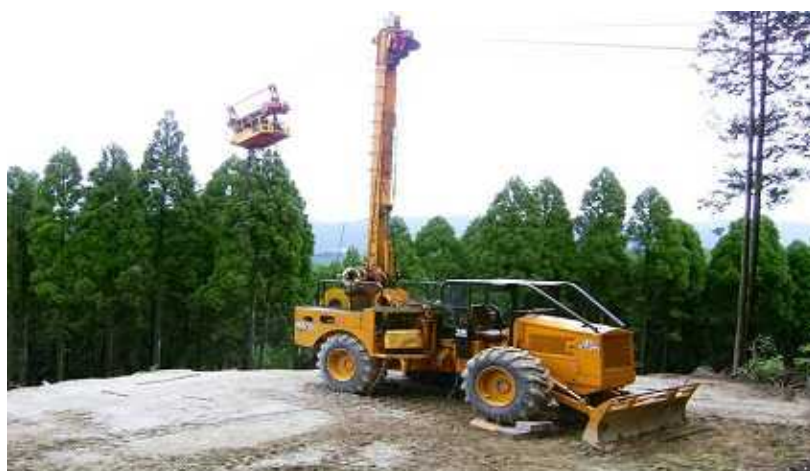
タワーヤーダの設置状況
