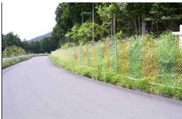
鹿防護柵設置事業 林道沿い・平成14年12月
