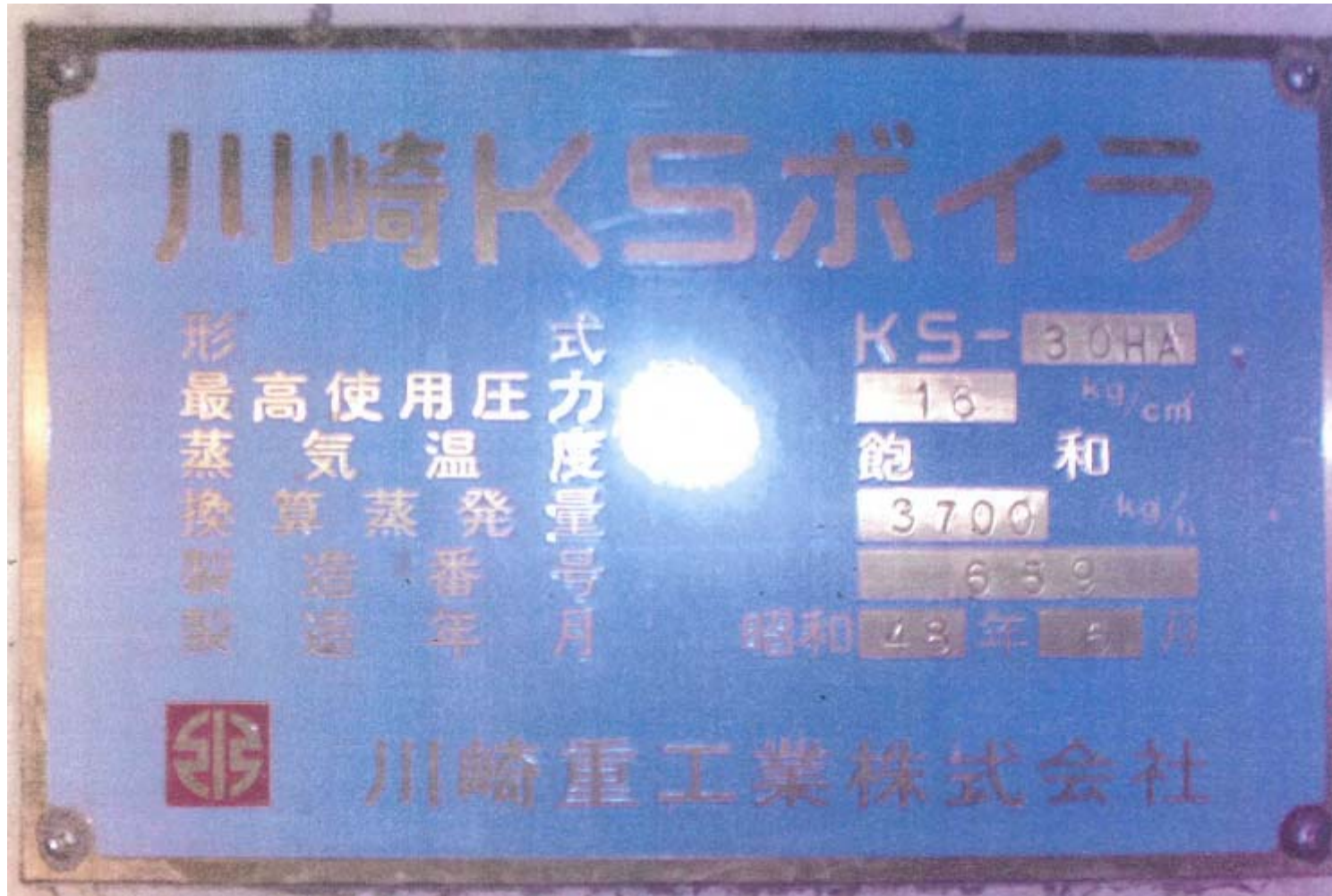
資料3-2 既設ボイラー名盤
