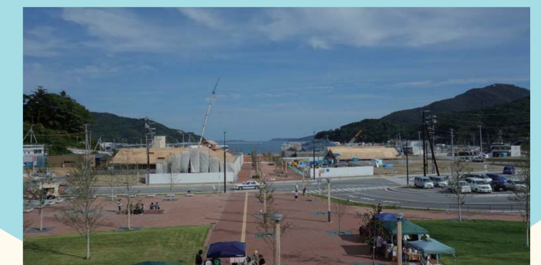
復興工事の様子
