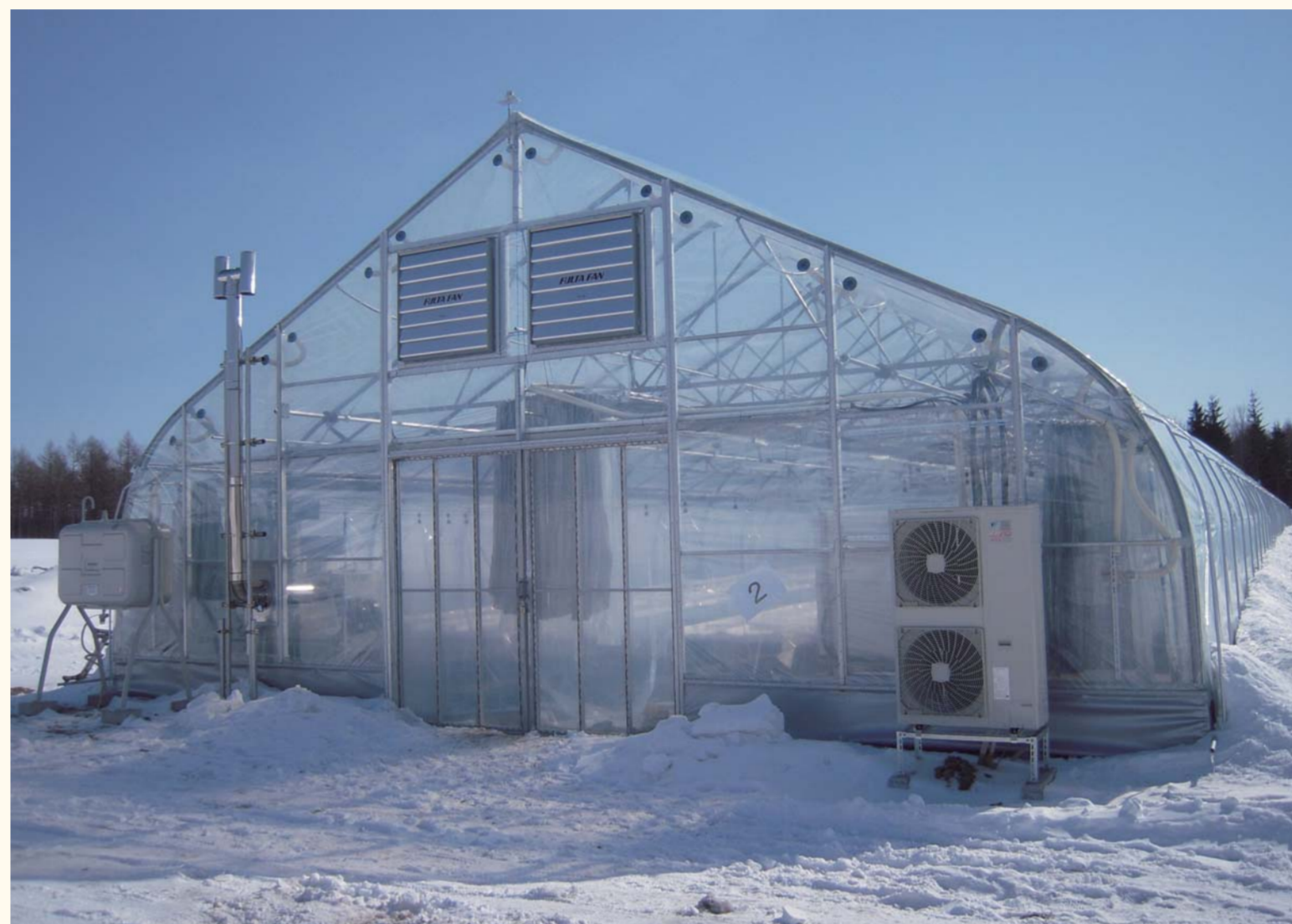
ヒートポンプを導入したビニールハウス
