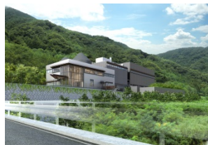
施工事例（発電所）
